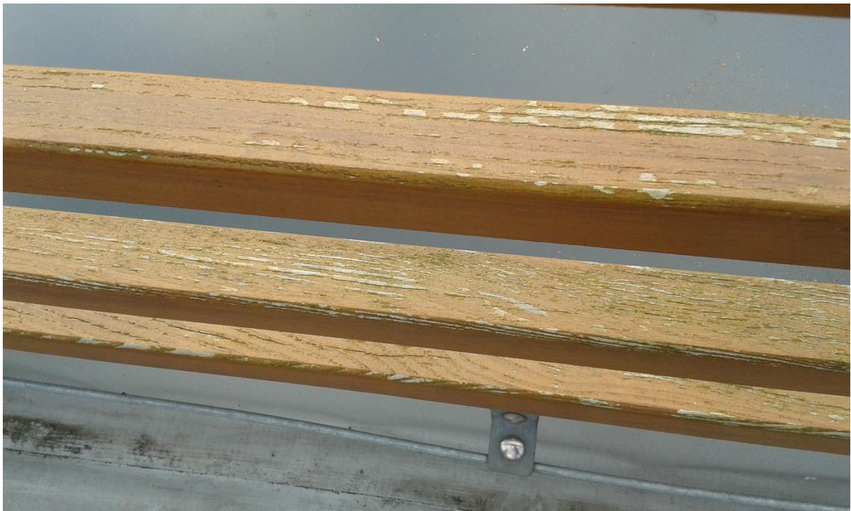
Fot. 1. Zdegradowane listwy elewacyjne
