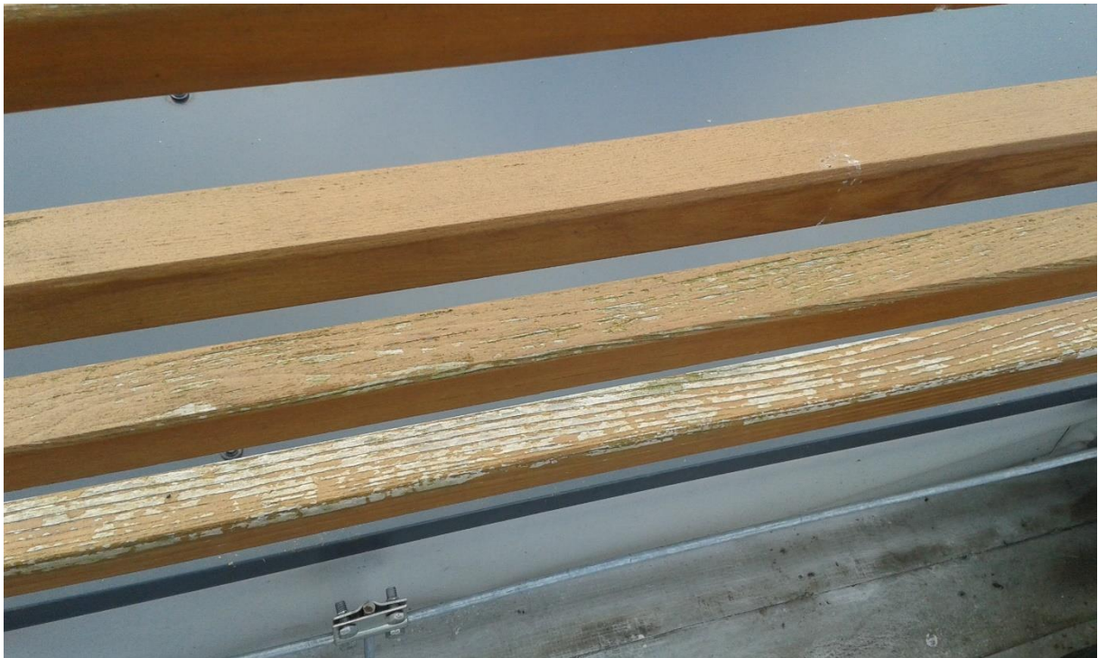
Fot. 2. Zdegradowane listwy elewacyjne
